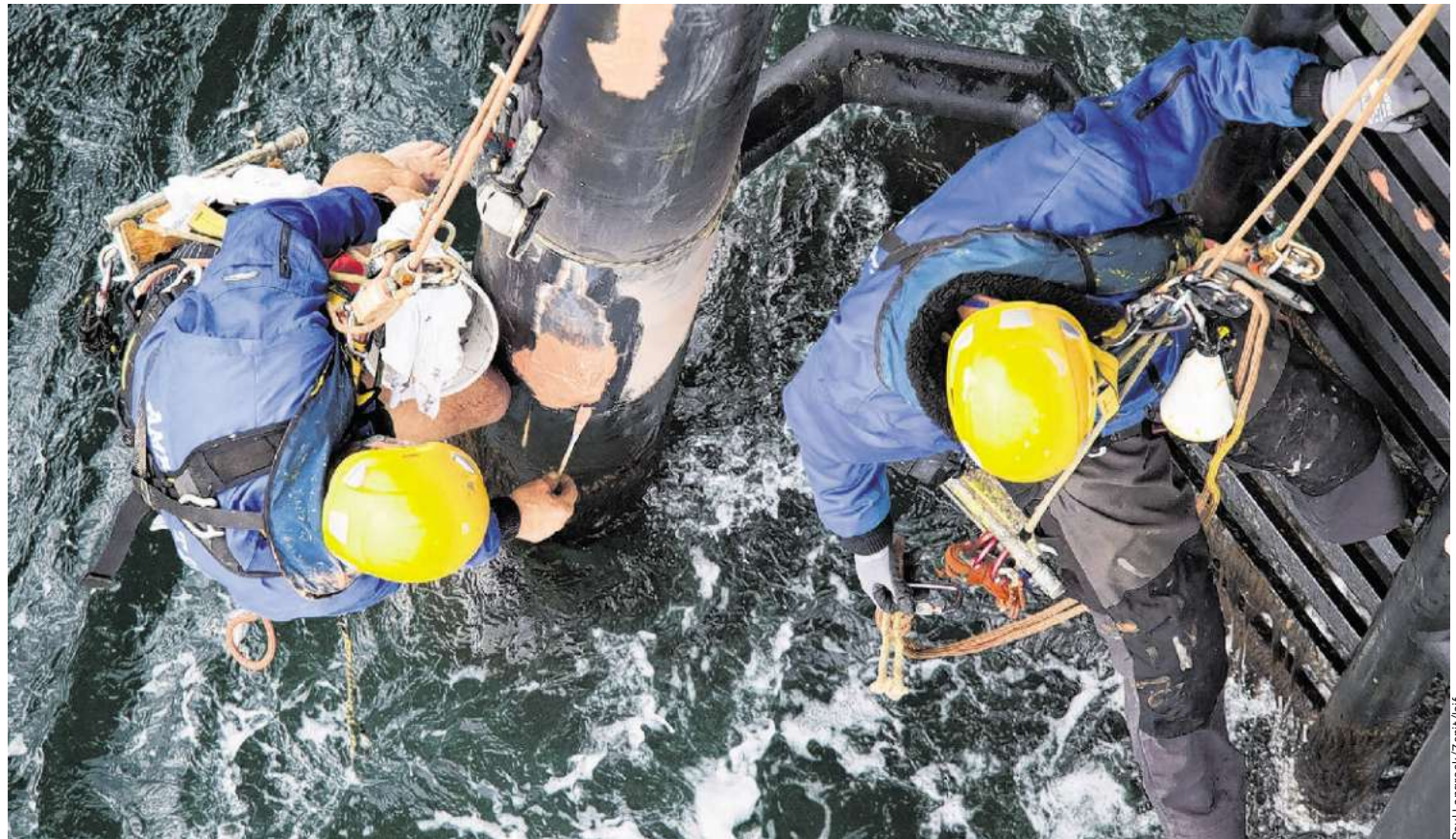
Arbeiter mit Rostschutzfarbe am Windpark Alpha Ventus in der Nordsee: Windkraftanlagen im Meer sind besonders anfällig gegen Korrosion.
