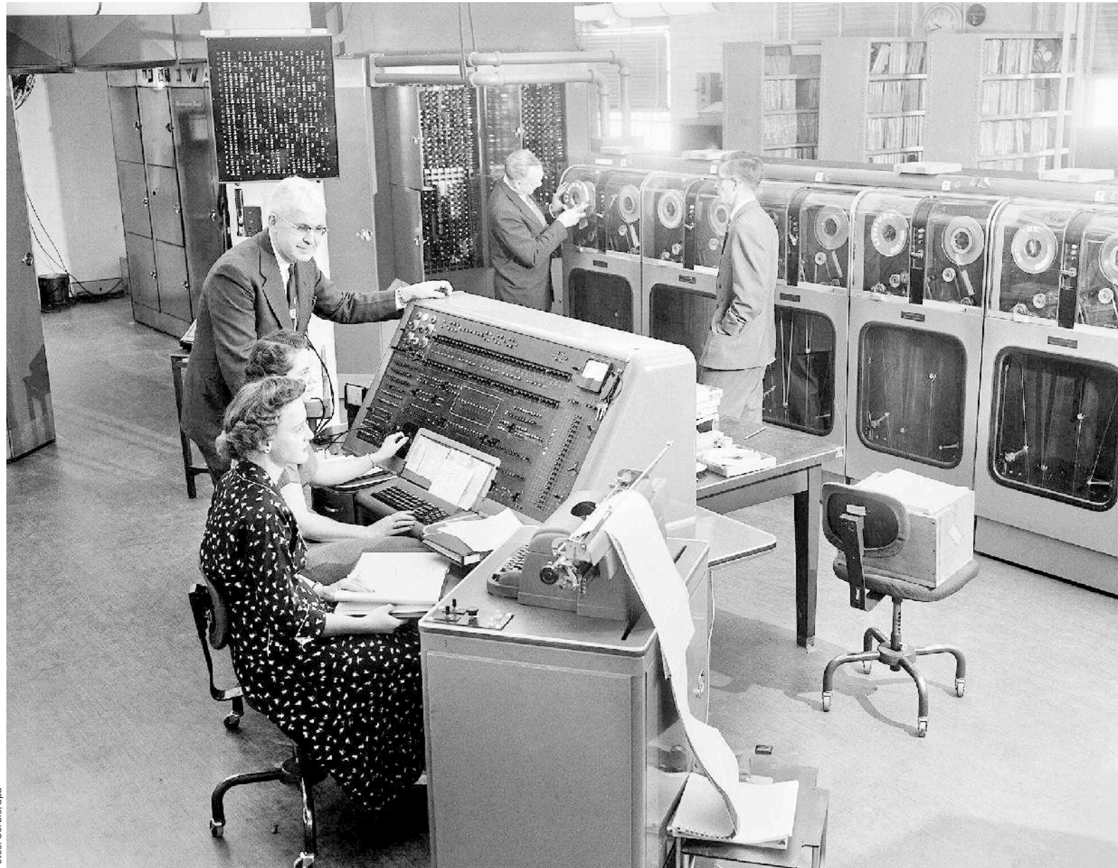
Leistungsexplosion: Der Univac 1 im US-amerikanischen Büro für Volkszählungen galt 1955 als Supercomputer – mit 1 905 Rechenoperationen pro Sekunde.
