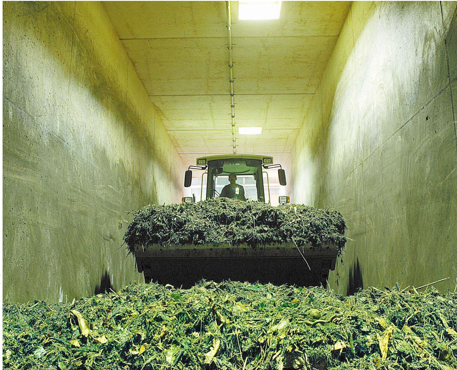
Energieträger der Zukunft: Bioabfall kann nicht nur zu Biokohle verarbeitet werden, sondern auch – wie in dieser Anlage – zu Biogas.
