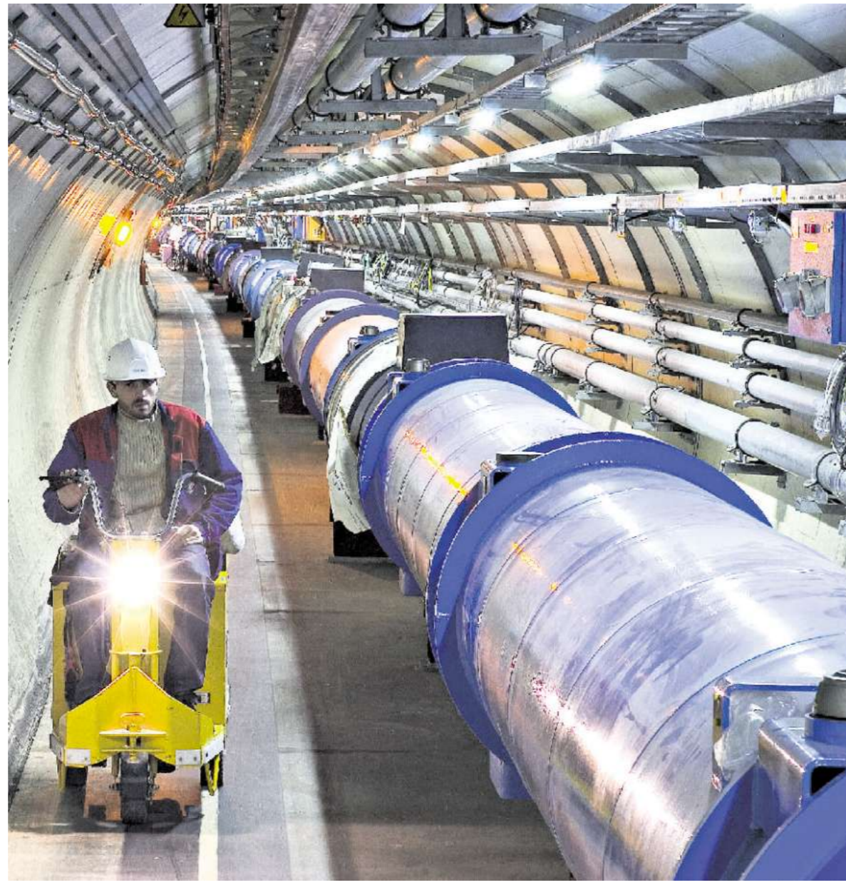
In dem 27 Kilometer langen Röhrenring werden Elementarteilchen in gegenläufiger Richtung nahezu auf Lichtgeschwindigkeit beschleunigt. Der Large Hadron Collider liegt 50 bis 175 Meter tief unter der Erde in der Nähe von Genf.
