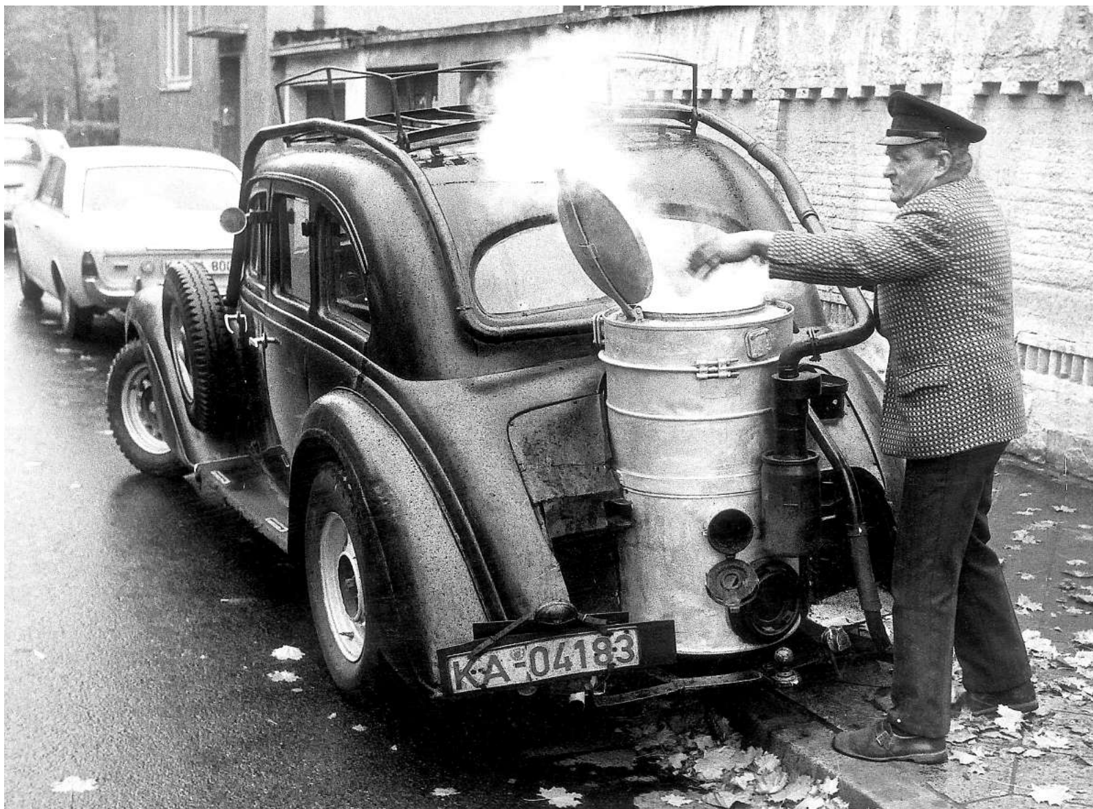
Es geht auch ohne Öl: Fahrzeuge mit Holzvergaser wurden während des Zweiten Weltkriegs gebaut.
